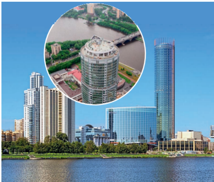
Рисунок 3 — Пример крышной котельной на башне «Исеть» — 52-этажный небоскреб в Екатеринбурге. АИТ мощностью 6 МВт запроектирован на отметке 130 м [11]
